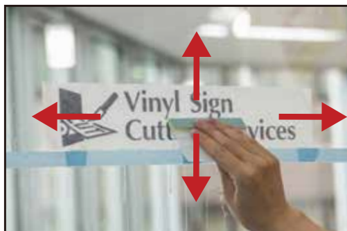
⑤ 继续揭开转移膜, 同时用刮板将贴纸牢固地压贴在表面上。
