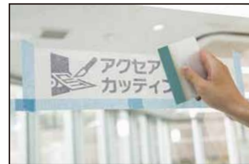
⑥ 用刮板刮压贴纸表面，直到文字贴纸下方的水分完全排出。
